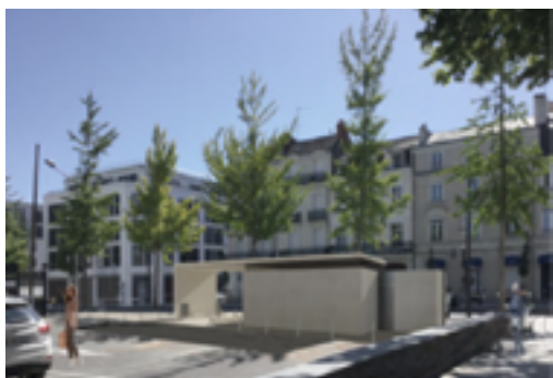
Façade ouest du local technique de signalisation ferroviaire Saint-Serge, rue de Rennes Dimensions de la façade : H318cm x L 816cm, soit 25,94m 2
