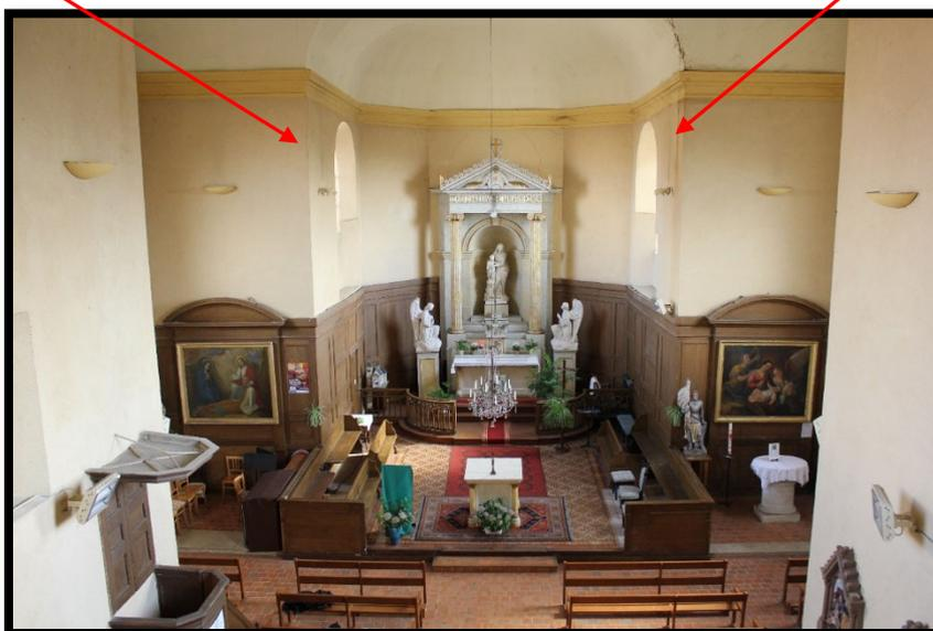
**Dimensions des verrières :** à titre indicatif, la largeur est de 170 cm sur une hauteur estimée de 230 cm composée d'un rectangle de 170 cm x 145 cm surmonté d'un arc de 85 cm de diamètre.
